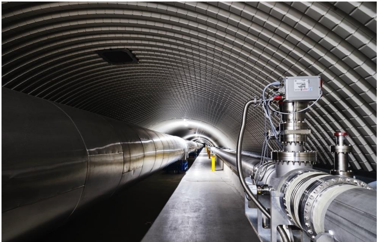
Figura 7: Uno dei tunnel di Virgo
