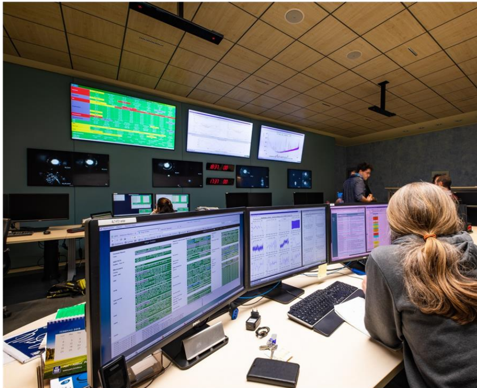
Figura 10: Sala di controllo di Virgo
